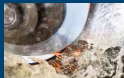
5. Préparation de surface plane
